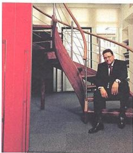
Tino Schreier (Menuiserie Kraemer) a conçu un escalier en acier et bois de noyer spécialement pour le salon.
