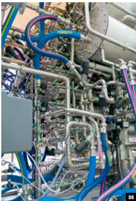
04. Le système de filtration ne fait pas appel à la chimie. Il repose sur des filtres en céramique dynamique ayant une porosité en taille Nano et retient donc les plus petites particules d'impuretés.
