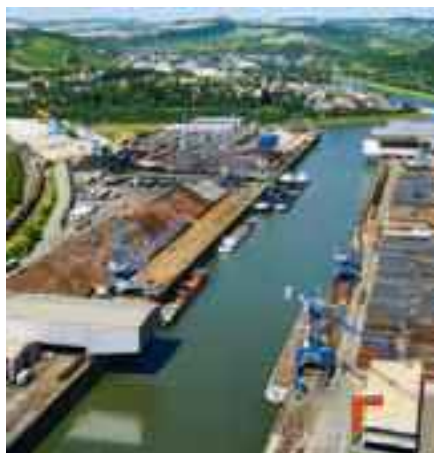
Port de Mertert
