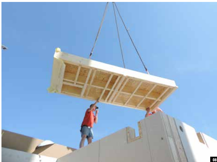
08. 09. 10. La résidence Nesto a été construite en très peu de temps grâce à une technique consistant à assembler des panneaux pré-usinés.
