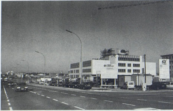
Le nouveau siège administratif à la Cloche d'Or (Gasperich) entre dans sa dernière phase de construction
