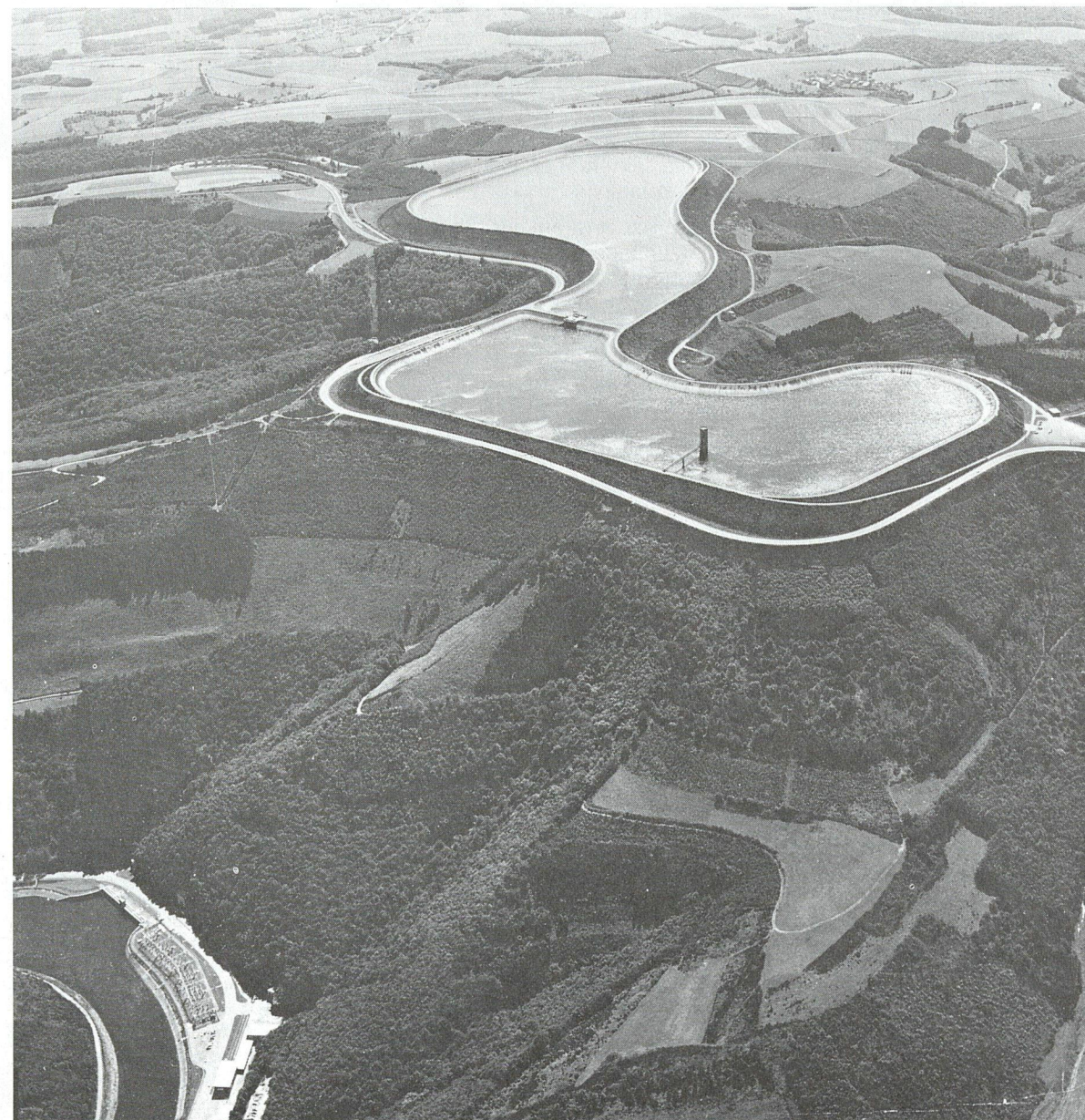
Luftbild des Speicherwerks der SEO in der Ardennenlandschaft bei Vianden.
