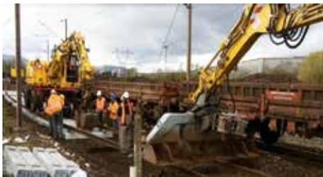
tes en peu de temps. Une des méthodes que Ferro-Tech a développée, c'est la rénovation de voies ferrées en flux tendu, sans dépôt des anciens rails. «La méthode classique consistait au dépôt de 200 mètres de voie, avec les traverses et à leur rénovation en une nuit. Considérant des sanctions pouvant atteindre 15.000 euros la minute de retard, le moindre ennui peut coûter cher en travaillant de cette façon. Nous avons développé une méthode
