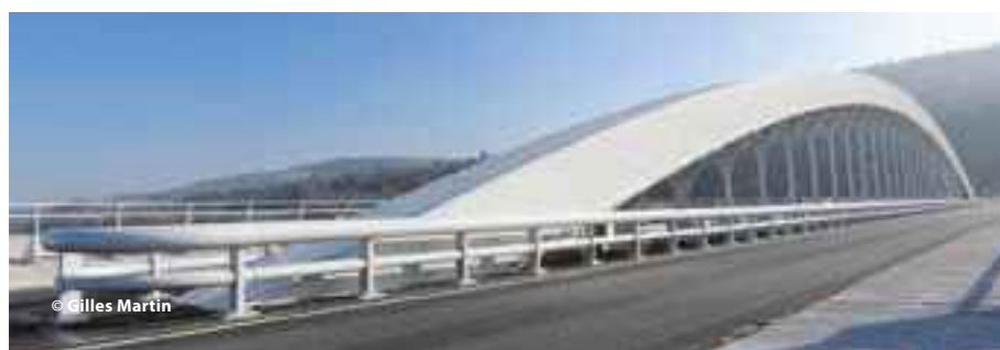
Le nouveau pont enjambant la Moselle pour relier les communes de Grevenmacher (L) et de Wellen (D)
