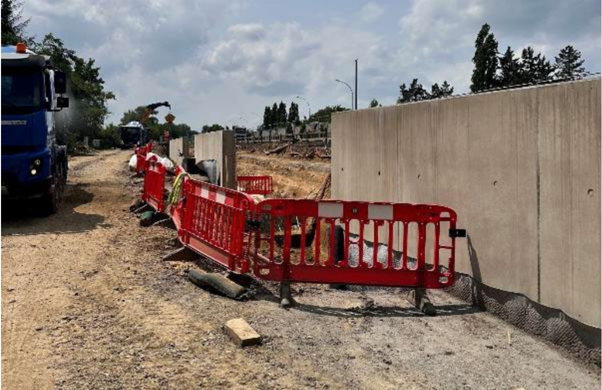
Photo 4 : Mur de soutènement supplémentaire – Phase 1 – Bretelle de sortie en provenance d'Esch
