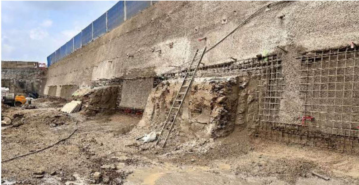
Photo 1 : Terrassement en pianotage à cause de conditions géologiques défavorables (mai 2024)
