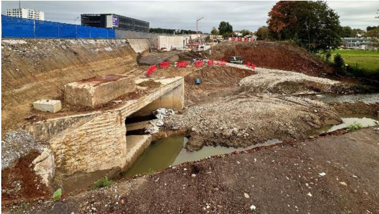
Photo 3 : Phase 1 - Terrassement pour la reconstruction d'une partie de l'ouvrage sur la Mess (oct. 2024)
