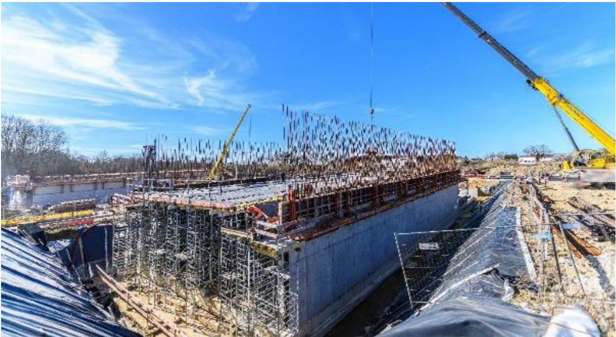
Photo 5 : Construction de l'ouvrage d'art 02 de l'OA 1106 (février 2019)
