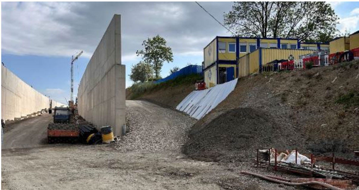
Photo 6 : Mur de soutènement multifonctionnel, permettant à la fois d'intégrer des mesures de protection acoustique et de réduire l'emprise en direction des propriétés privées adjacentes, – Phase 1 – Bretelle d'accès en direction de Luxembourg
