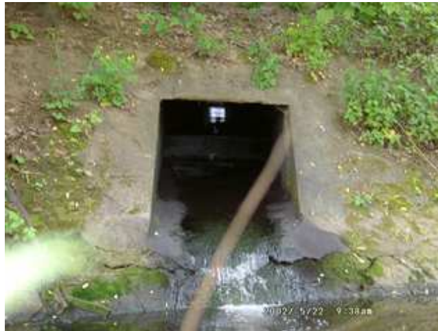
Figure 5: Canalisation de sortie du bassin de rétention d'ArcelorMittal
