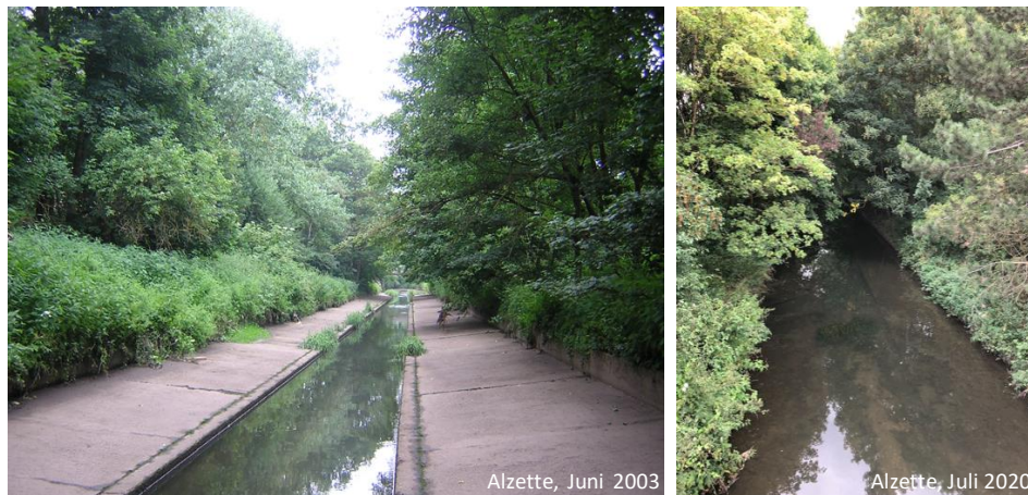
Abbildung 7: Betoniertes Bachbett (links) VS renaturiertes Bachbett (rechts) am südlichen Rand vom Pudel
