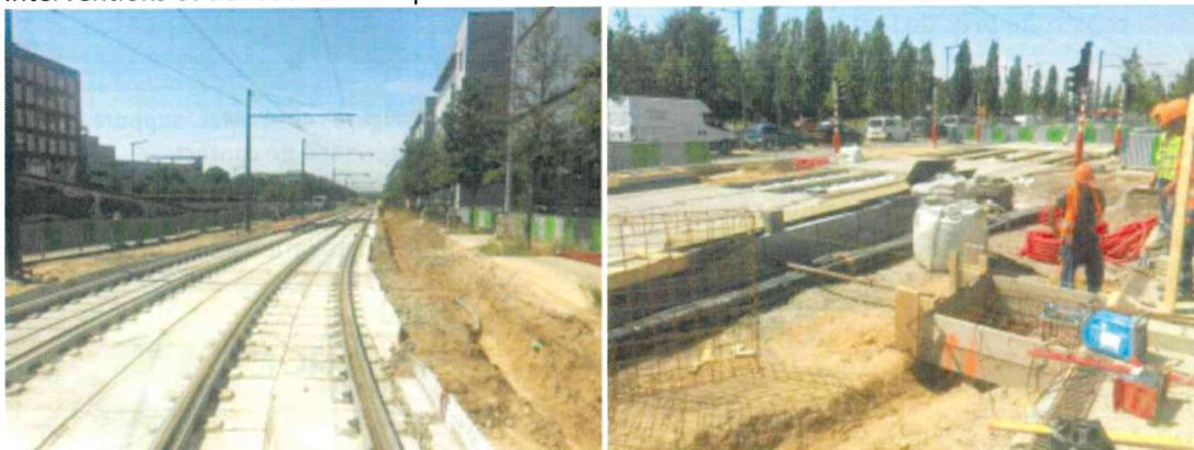
Figure 41 : Travaux de plateforme du tram et des quais sur l'avenue Kennedy
