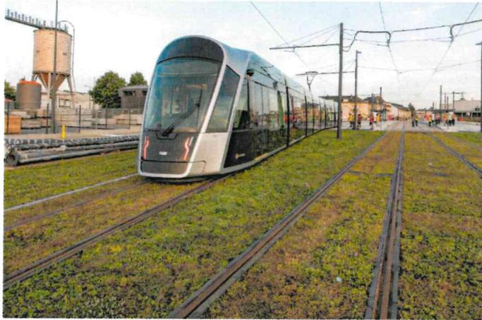
Figure 34 : Plateforme végétalisée sur la nouvelle N3 à Bonnevoie
