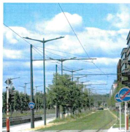
Figure 40 : Mât support de la ligne aérienne de contact
